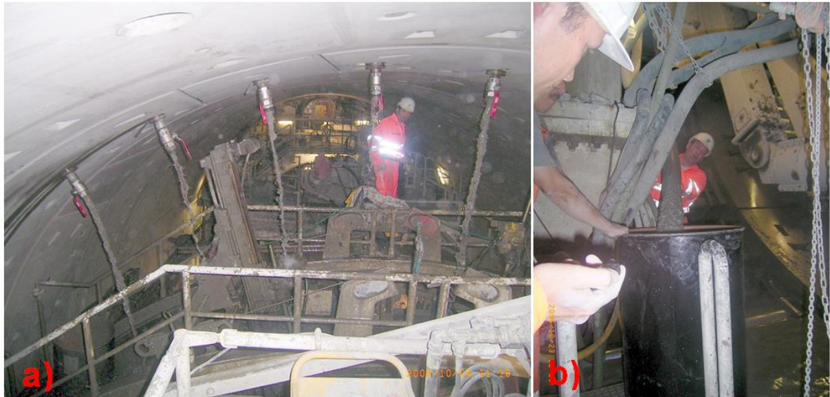
Abbildung 6.32: a) Messbare Wasserzutritte aus den Bohrungen eines Injektionsschotts b) Messung des Überlaufs der Abbaukammer während der Teilabsenkung des Erdbreis. „Auslitern“ mit einem 200-Liter-Fass
