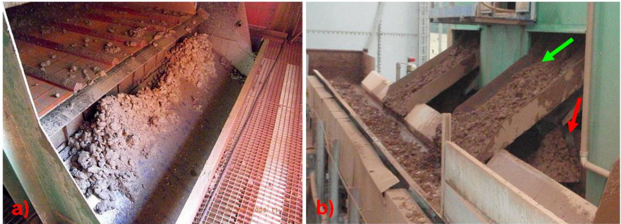
Abbildung 6.98: a) Verklebung der Siebrutschen [60] b) Ableitung des Ausbruchsmaterials auf ein Förderband über eine Rutsche (Transportweg: grüner Pfeil) Ein Teil des Ausbruchsmaterials wird infolge bereichsweise verklebter Rutschen nicht auf das Förderband, sondern in den unteren Bereich der Separationsanlage abgeleitet (roter Pfeil) [60]
