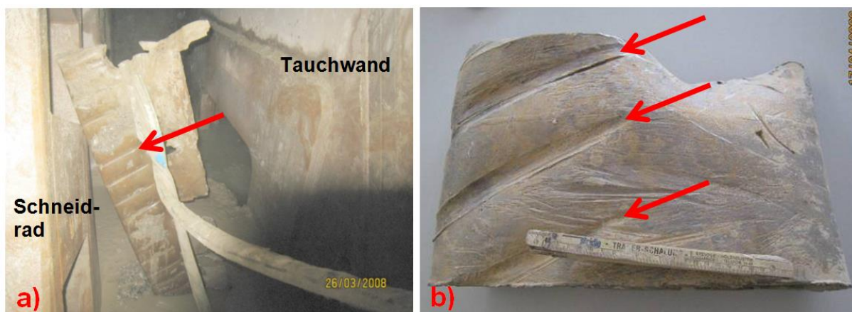
Abbildung 7.30: Bei einem Hydroschild unerwartet angetroffene Verrohrung einer Erkundungsbohrung [59, modifiziert] a) Bergung der Verrohrung mit Werkzeugspuren (Pfeil) b) Teil einer Verrohrung mit Werkzeugspuren (Pfeile)
