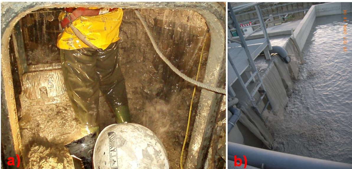
Abbildung 6.31: a) Blick durch die Luke der Druckluftschleuse in die Abbaukammer: Werkzeugkontrolle innerhalb der Störzone b) Überlauf der Wasseraufbereitungsanlage in ein Pufferbecken. Das überlaufende Wasser entspricht etwa dem gleichzeitig auf der TVM beim Einstieg zulaufenden Bergwasser
