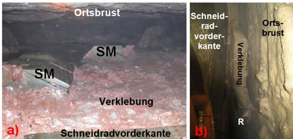
Abbildung 6.86: Verklebungsmaterial zwischen zurückgezogenem Schneidrad und Ortsbrust a) Verklebungsmaterial an der Schneidradvorderseite (SM: verschlissene Schälmesser) [60, 61] b) Von der Schneidradvorderkante abgelöste Verklebungsscheibe (R: Ripper) [59]
