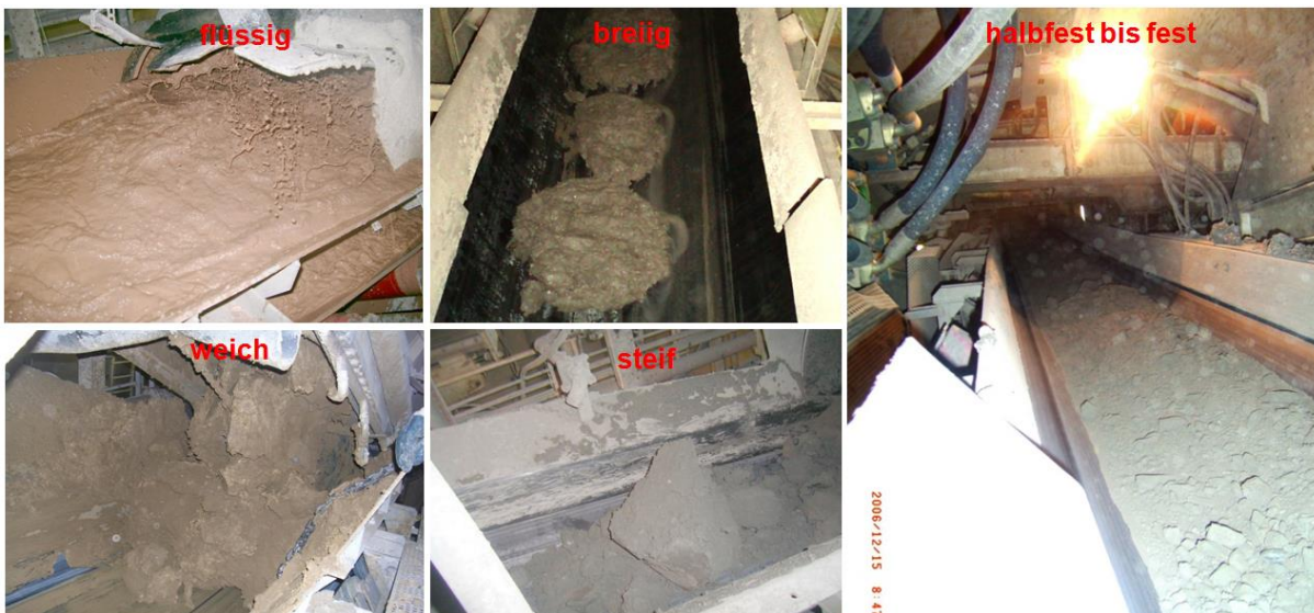
Abbildung 6.37: Unterschiedliche Konsistenzbereiche des Ausbruchsmaterials infolge Bergwassers
