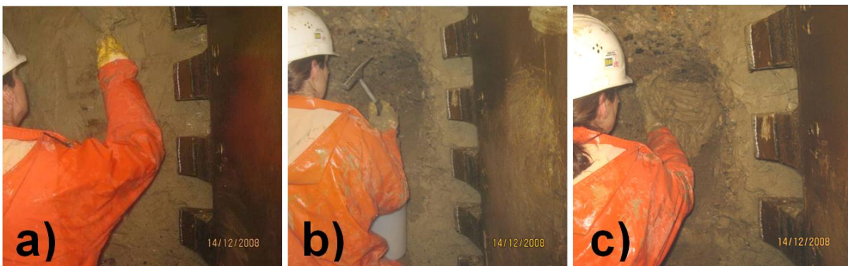
Abbildung 6.3: a) Ingenieurgeologische Dokumentation bei einem Hydroschildvortrieb in Kiesen a) Abschälen des Filterkuchens b) Dokumentation und Beprobung c) Erneutes Versiegeln des freigelegten Ortsbrustbereichs zur Minimierung von Druckluftverlusten
