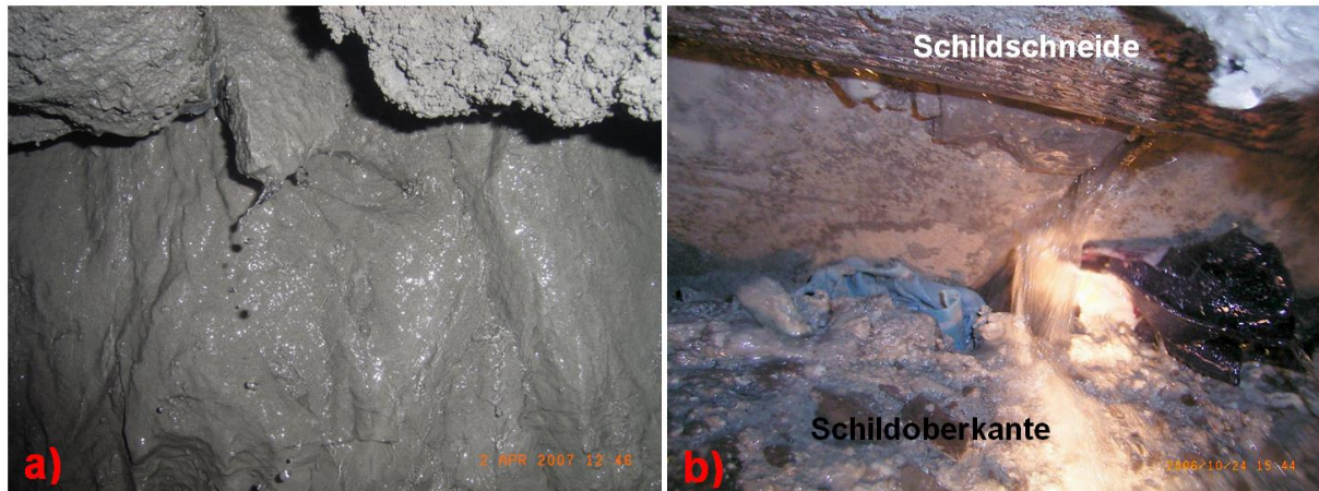
Abbildung 6.21: a) Wasserzutritte aus Sandsteinen an der Ortsbrust b) Wasserzutritt aus einer offenen Kluft der Fischechiefer im Firstbereich
