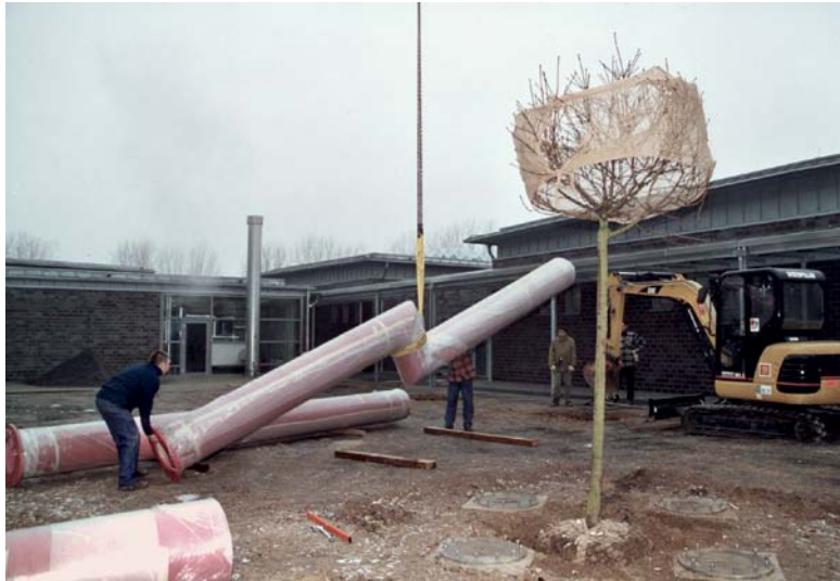
Abb. 31: Aufstellung der Säulen für die Akademie des Handwerks in Bochum, 2001
