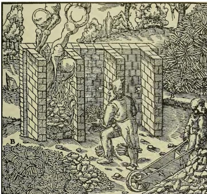
**Abb. 2.11** Das Rösten des Kupfers in einem offenen Ofen. Reisig (kleine Holzspate) und zerleinerte Kupferkuchen liegen vor dem Ofen. A) Kupferkuchen, B) Reisig, C) Ofen (Nach Agricola Hoover & Hoover, 1950).
