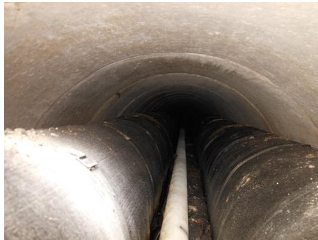
Abbildung 47: Blick in Haubenkanal, kein Wurzeleinwuchs sichtbar (links, Bildquelle AGFW)
