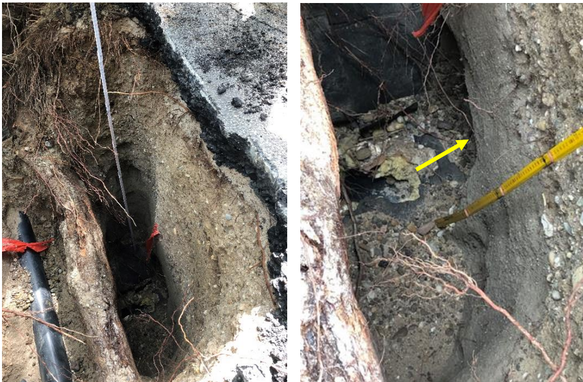
Abbildung 46: Fein- und Starkwurzel oberhalb der Bettung (links) und Feinwurzeln in der Bettung (rechts, u.a. gelber Pfeil)
