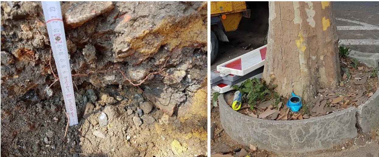
Abbildung 48: Vereinzelt Feinwurzeln an Grabenwand (links), hochgesetzte Baumscheibe (rechts)
