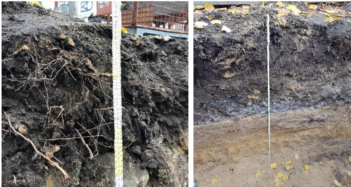
Abbildung 50: Wurzelgeflecht in Vegetationstragschicht (links) und keine sichtbaren Wurzeln in Sandbettung (rechts)
